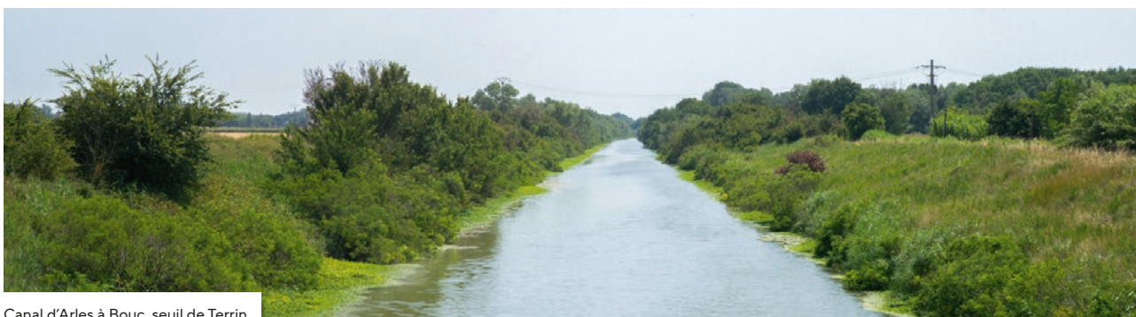
Canal d'Arles à Bouc, seuil de Terrain
