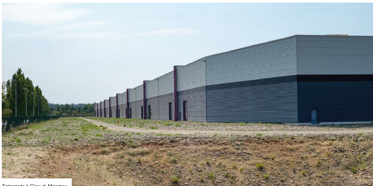
Entrepôts à Clesud, Miramas
