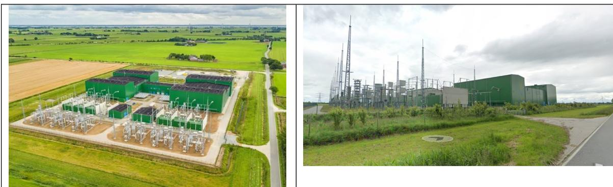
Station de conversion 2\*700MW, +/- 525 kV. La superficie du terrain (avec les dégagements) est d'environ 400x250m<sup>2</sup> = 10 ha, et celle de l'installation électrique est de 250x200 m<sup>2</sup> = 5 ha. Des câbles souterrains ont été posés sur une longueur de 54 km pour rejoindre la mer. Les travaux de pose du câble ont nécessité un corridor d'une largeur de 20 mètres (<https://www.youtube.com/watch?v=0HUFXuF8QDM>). La vidéo illustre la complexité des zones de franchissement.
